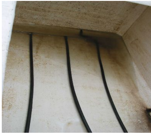
Фиг. 7: Дифузор, разположен на дъното на резервоар от фибростъкло.
